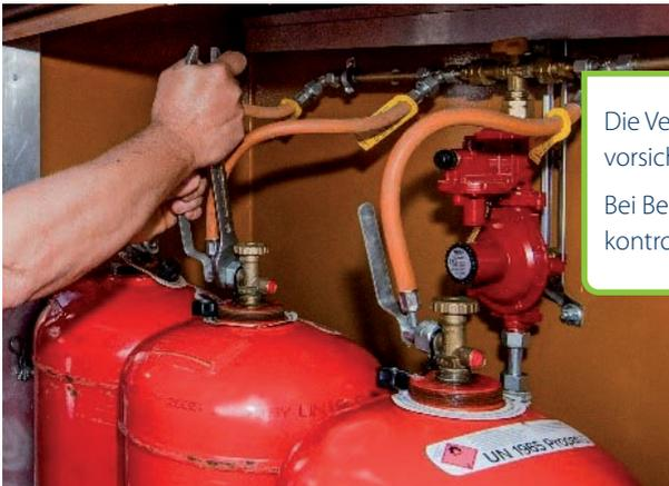
Die Verbindung muss dann vorsichtig nachgezogen werden. Bei Bedarf die Dichtungen kontrollieren.
