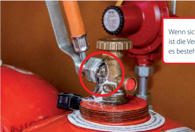
Wenn sich dabei Blasen bilden, ist die Verbindung undicht und es besteht Explosionsgefahr.
